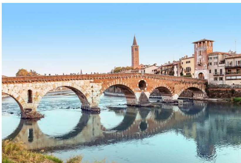
Il Ponte Pietra è il più antico ponte di Verona sul fiume Adige, l'unico rimasto intatto di quelli risalenti all'epoca romana.
